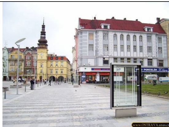
Náměstí v Ostravě po rekonstrukci s použitím světlého dláždění (zdroj: www.OSTRAVA.unas.cz )
