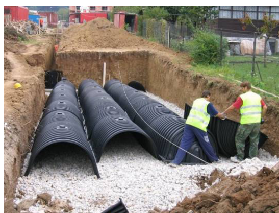
Instalace zasakovacích tunelů (zdroj: www.asio.cz )
