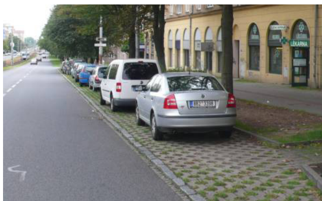
Zatravňovací tvárnice pod parkovacími plochami v Porubě (zdroj: vlastní foto)
