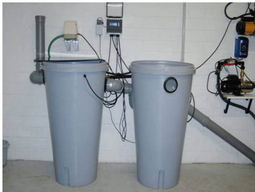
Zařízení na recyklaci šedé vody (zdroj: www.tzb-info.cz )
