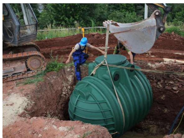
Instalace plastového zásobníku k jímání dešťové vody (zdroj: www.nicoll.cz )
