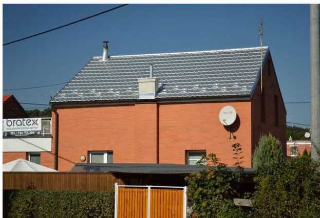
Bílá kovová střecha české produkce (zdroj: www.krytiny-strechy.cz )
